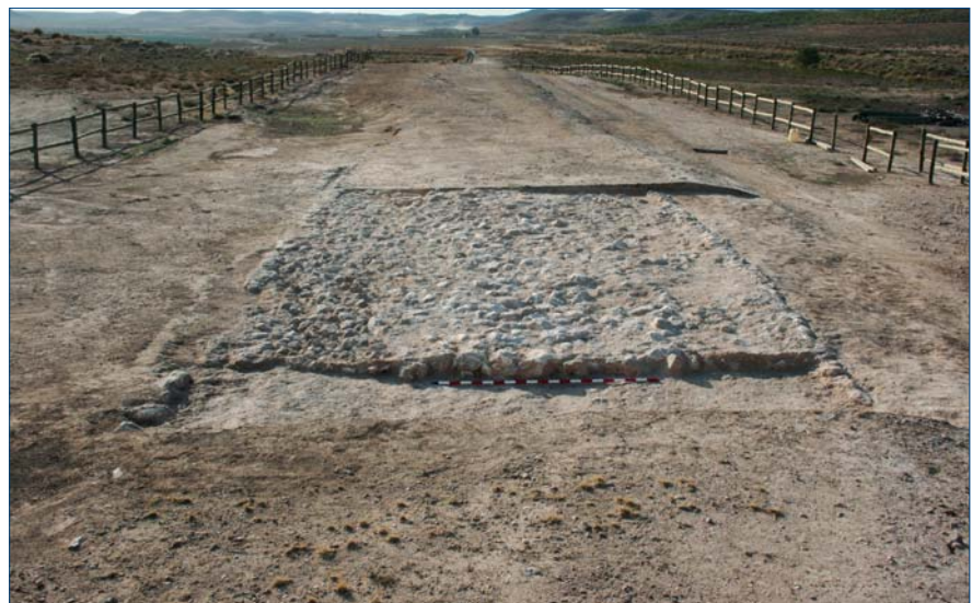
Estructura del afirmado de una vía romana sobre terrenos duros. Vía de Italia a Hispania, en Ablitas (Navarra)
