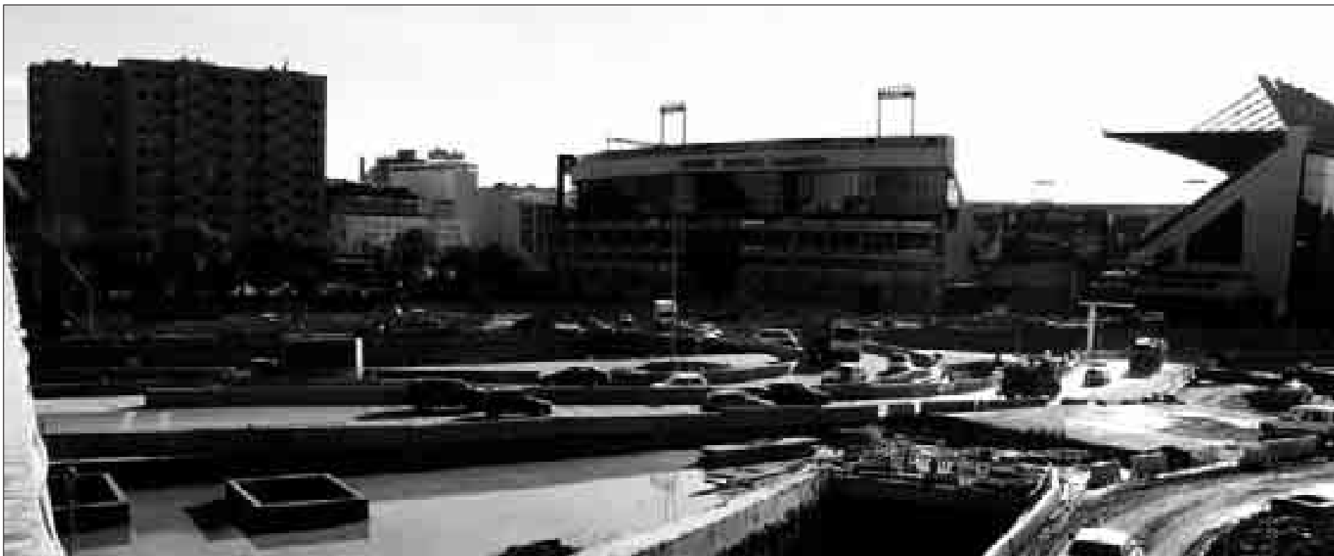
Imagen de las obras de la M-30 que se están realizando en los alrededores del Vicente Calderón, el terreno protagonista de la operación de recalificación que pretende el Atlético de Madrid. / CHEMA TEJEDA
