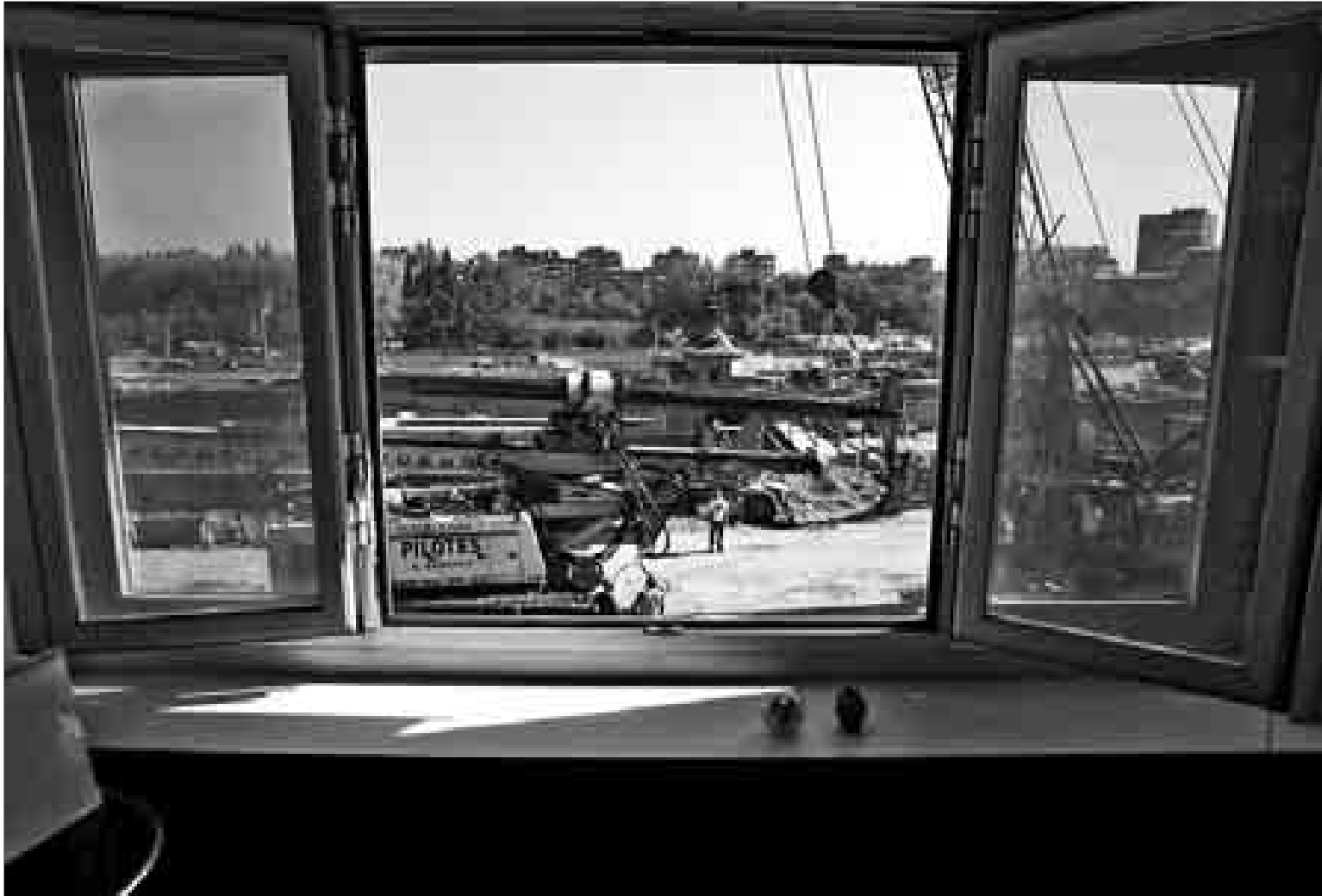
La vivienda del periodista, el pasado jueves, frente a las obras de enterramiento de la M-30, con las grúas trabajando indiscriminadamente las 24 horas del día. / CARLOS BARAJAS
