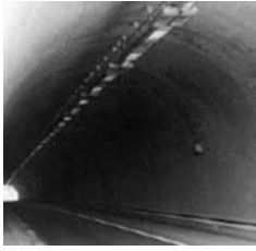
10.1.1 a.2 irudia. — Ganga-formako tunel estua; ilara albo baterantz egon daiteke bide azkarraren gainean (luminariarekiko segurtasun-distantzia: 0,10 m)
